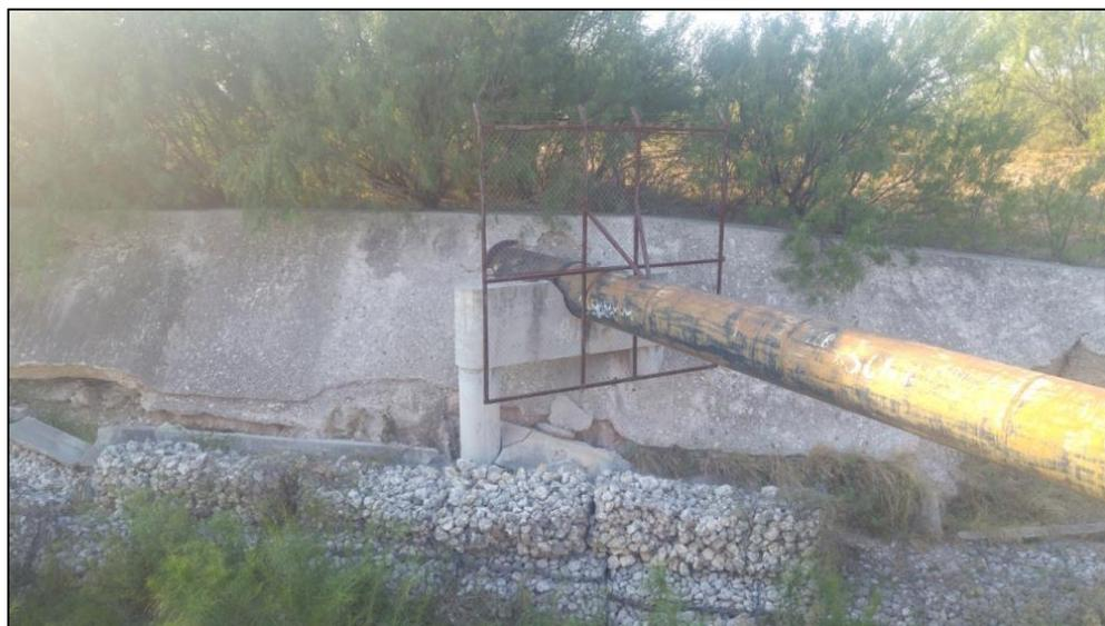
El canal de drenaje pluvial Santa Martha se encuentra a 231 metros al noreste del canal La Misión y también drena directamente hacia el río Bravo. El canal Santa Martha, construido en 2004, tiene una longitud de 950 metros y una capacidad de aproximadamente 7 m<sup>3</sup>/s. Aproximadamente 137.5 metros del canal se han erosionado por completo, como se muestra en la Figura 5.
