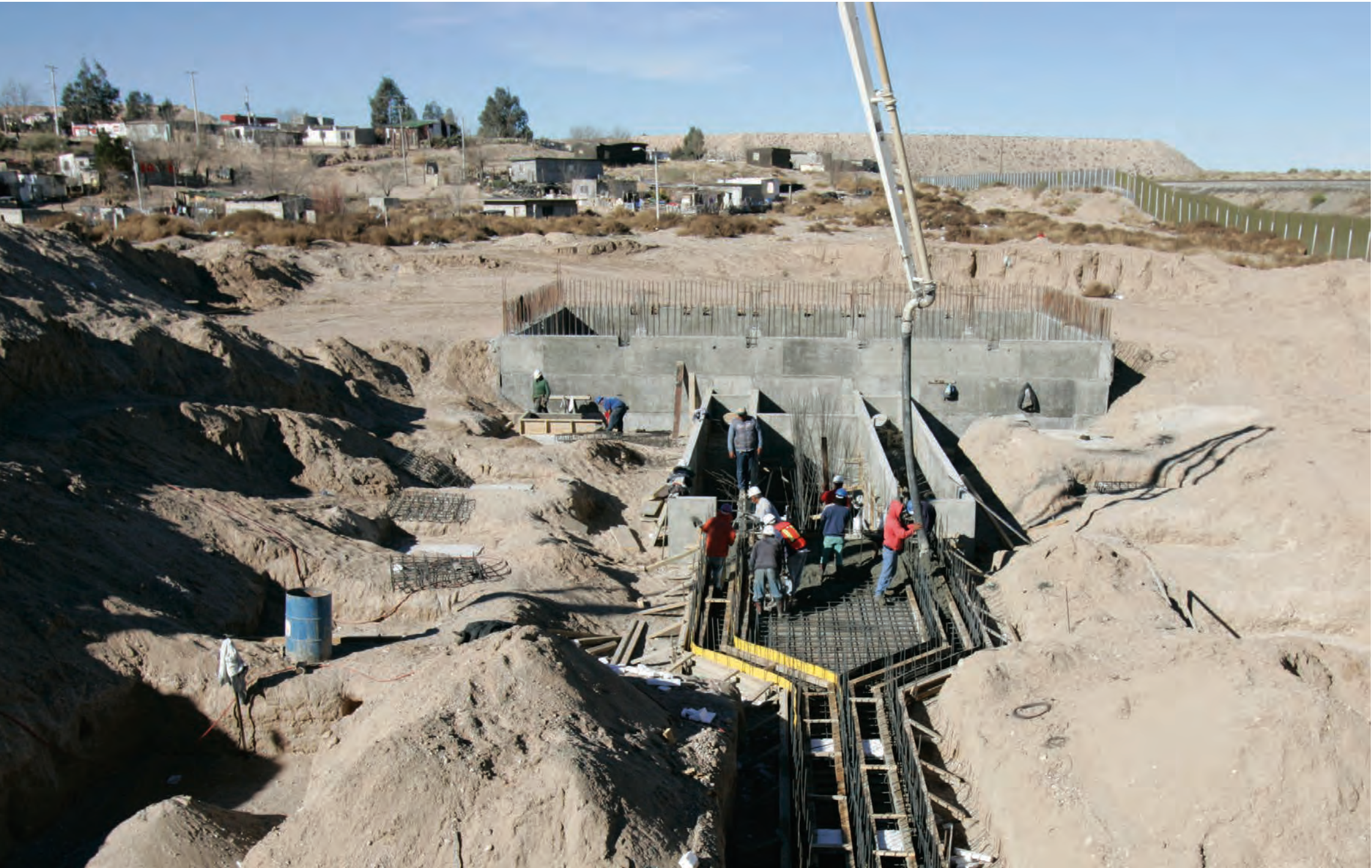
La construcción de una nueva estación de bombeo y emisor fue parte del Proyecto de Alcantarillado, Saneamiento y Reuso de Aguas Tratadas en la Colonia Anapra de Cd. Juárez, Chihuahua. (Certificado: Octubre de 2006 / Concluido: Marzo de 2010)
