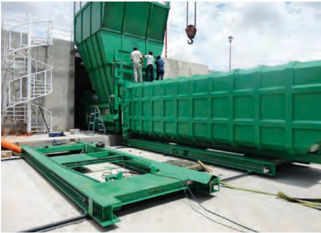
La COCEF y el BDAN han apoyado la construcción o ampliación de 16 rellenos sanitarios en ambos lados de la frontera, tal como el de Ojinaga, Chihuahua. (Certificado: Octubre de 2001 / Concluido: Noviembre de 2008)
